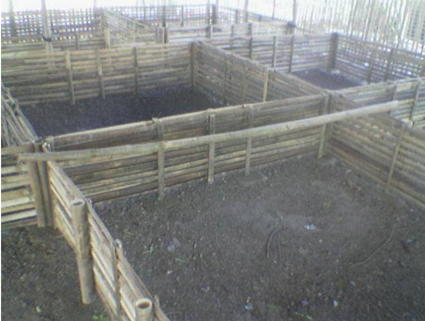
Rangka kolam menggunakan bambu
